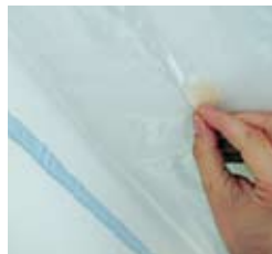
Fixes vapour barrier
