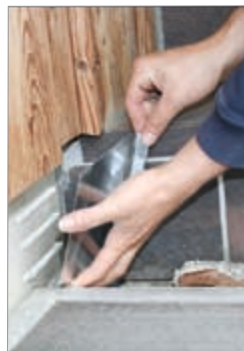
Edelstahlblech auf Betonsockel kleben
