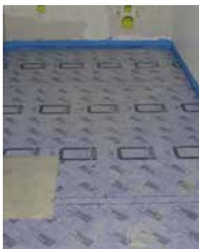
Solo dopo l'incollaggio ermetico del foglio sigillante OTTOFLEX su tutti i punti di sovrapposizione, gli angoli e i raccordi, è possibile procedere con la posa del rivestimento. Non sono richiesti tempi di attesa.
