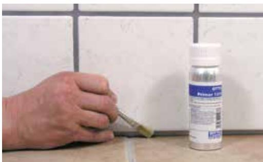
3. Applicare eventualmente il fondo sui fianchi di adesione, utilizzando un prodotto **OTTO Primer o Cleanprimer** adeguato, con un pennello morbido in caso di substrati assorbenti oppure con un panno morbido in caso di substrati non assorbenti.
