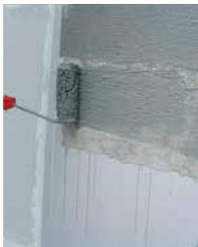
Se OTTOFLEX rivestimento sigillante viene posato con un rullo a pelo corto, è necessario dare tre mani, per garantire lo spessore di 2 mm necessario per il prodotto asciutto.
