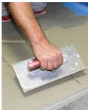
Applicare l'adesivo per piastrelle con una spatola dentata 4 x 4 mm sull'intera superficie (prestare attenzione al tempo di lavorabilità dell'adesivo).
