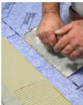
Stendere il foglio sigillante OTTOFLEX sull'intera superficie ricoperta di adesivo. Per la posa del foglio, passare il lato liscio della spatola dentata o una spatola liscia con andamento obliquo sul foglio esercitando una leggera pressione. Evitare in modo assoluto di incamerare bolle d'aria.
