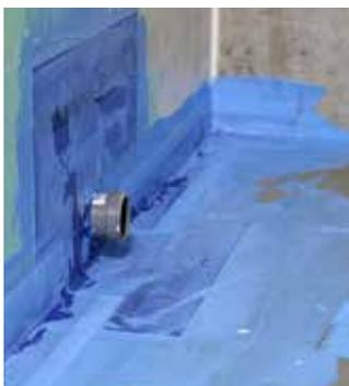
Per la sigillatura di angoli interni ed esterni, di bordi e tubazioni si possono utilizzare i prodotti della gamma OTTOFLEX. (nastro OTTOFLEX per angoli interni ed esterni, manicotto sigillante per pavimenti e pareti e nastro sigillante OTTOFLEX). Tutti questi prodotti devono però essere incollati in modo ermetico sui punti di sovrapposizione. I prodotti OTTOFLEX possono essere applicati prima o dopo la posa del foglio sigillante.
