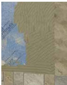
Per la posa delle piastrelle con tecnica a letto sottile, l'adesivo deve essere applicato direttamente sul foglio sigillante. Sopra di questo si poseranno le piastrelle. La scelta dell'adesivo per piastrelle dipende dal tipo di rivestimento e dalle sollecitazioni al quale è sottoposto.
