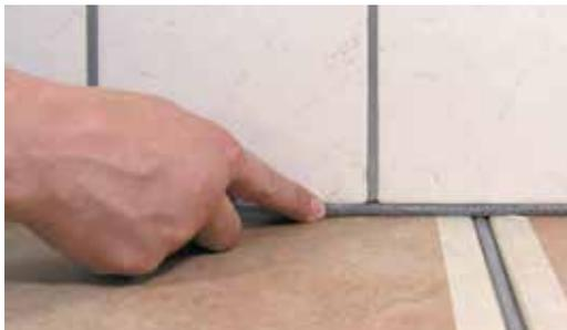
2. Sottoriempire il giunto con la **Guarnizione PE di riempimento OTTO** della misura adeguata. La misura deve essere scelta in modo che la guarnizione di riempimento possa essere infilata nel giunto esercitando una certa pressione. Solo in questo modo si garantisce il completo riempimento del giunto e quindi la limitazione della profondità del giunto stesso.
