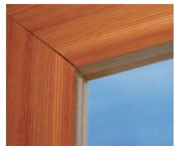
Im Bild kombiniert das geklebte Holzfenster die überlappend geklebte Glasfläche des Flügels mit einer dem Blendrahmen vorgesetzten Aluminiumschale. Durch dieses fast filigran wirkende Profil entsteht eine neue Fensteroptik. Vielfältige Farbausführungen lassen Spielraum für gestalterische Akzente. Das neuartige Design ermöglicht mehr Glas mit weniger Rahmen.
