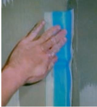
Für Innen- und Außenecken, Kanten sowie an Rohrdurchführungen können die Produkte aus dem OTTOFLEX-System verwendet werden (Innen-/Außenecke, Boden- und Wanddichtmanschette sowie Dichtband). Diese müssen im Überlappungsbereich mit OTTOCOLL® M 500 dicht verklebt werden.
