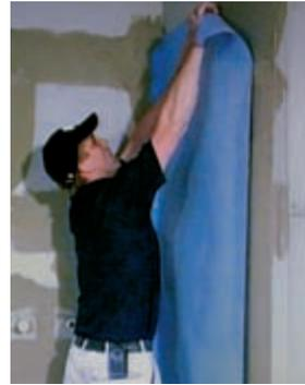
OTTOFLEX Abdichtbahn vollflächig in den Kleber eindrücken. Zum Eindrücken empfiehlt sich die Glattseite der Zahnpachtel oder eine Glättspachtel, die unter Druck schräg über die OTTOFLEX Abdichtbahn geführt wird. Lufteneinschlüsse müssen unbedingt vermieden werden.
