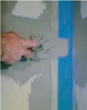
Erst wenn die OTTOFLEX Dichtbahn mit allen Überlappungen, Ecken und Anschlüssen dicht verklebt ist, kann mit dem Aufbringen des Belages begonnen werden. Eine Wartezeit ist nicht erforderlich.
