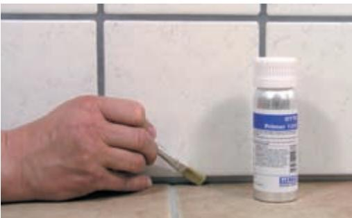
3. Grundieren der Haftflanken mit dem passenden **OTTO Primer oder Cleanprimer** und einem weichen Pinsel bei saugenden Untergründen oder mit einem weichen Tuch bei nicht saugenden Untergründen.
