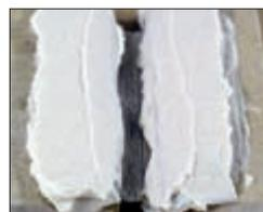
Mit einer Spachtel die Paste gleichmäßig verteilen, wobei eine Auftragstärke von min. 5 mm erreicht werden muss.
