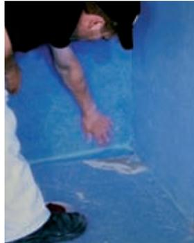
Zur Fliesenverlegung im Dünnbettverfahren ist der Fliesenkleber direkt auf die OTTOFLEX Abdichtbahn aufzutragen. Darauf sind die Fliesen vollsatt zu verlegen. Die Wahl des Fliesenklebers ist auf die Belagsart und -beanspruchung abzustimmen.
