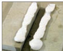
OTTOSEAL® StainEx auf die zu reinigende Fläche auftragen.
