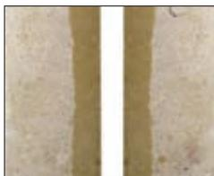
Den Dichtstoff mechanisch vollständig aus der Fuge entfernen.
