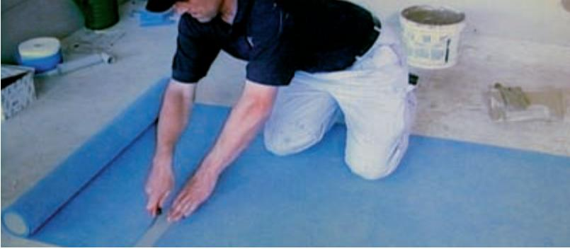
Die OTTOFLEX Abdichtbahn auf gewünschtes Format zuschneiden.
