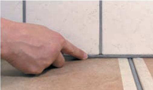
2. Hinterfüllen der Fuge mit der passenden Größe der **OTTOCORD PE-B2 Rundschnur**. Die Rundschnur muss von der Größe so gewählt werden, dass sie mit einem gewissen Druck eingebracht werden muss. Nur so ist gewährleistet, dass die Fuge komplett ausgefüllt und die Fugentiefe somit begrenzt ist.
