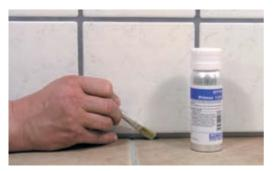
Grundieren der Haftflanken mit dem passenden OTTO Primer oder Cleanprimer und einem weichen Pinsel bei saugenden Untergründen oder mit einem weichen Tuch bei nicht saugenden Untergründen.
