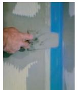
Erst wenn die OTTOFLEX Dichtbahn mit allen Überlappungen, Ecken und Anschlüssen dicht verklebt ist, kann mit dem Aufbringen des Belags begonnen werden. Eine Wartezeit ist nicht erforderlich.
