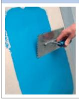
Die OTTOFLEX Flüssigfolie kann mit einer Glättspachtel aufgetragen werden, wobei darauf zu achten ist, dass die gesamte Fläche gleichmäßig beschichtet ist.
