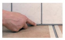
2. Hinterfüllen der Fuge mit der passenden Größe der OTTOCORD PE-B2 Rundschnur. Die Rundschnur muss von der Größe so gewählt werden, dass sie mit einem gewissen Druck eingebracht werden muss. Nur so ist gewährleistet, dass die Fuge komplett ausgefüllt und die Fugentiefe somit begrenzt ist.
