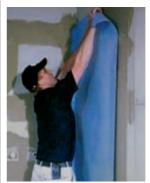
OTTOFLEX Abdichtbahn vollflächig in den Kleber eindrücken. Zum Eindrücken empfiehlt sich die Glattseite der Zahnspachtel oder eine Glättspachtel, die unter Druck schräg über die OTTOFLEX Abdichtbahn geführt wird. Lufteinschlüsse müssen unbedingt vermieden werden.
