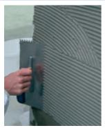
Beim Aufbringen der OTTOFLEX Dichtungsschlämme mit einer Zahnspachtel ist ein zweimaliger Auftrag erforderlich, um die benötigte Trockenschichtstärke von 2 mm zu erhalten.
