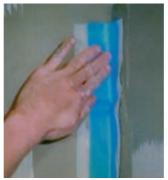
Für Innen- und Außenecken, Kanten sowie an Rohrdurchführungen können die Produkte aus dem OTTOFLEX-System verwendet werden (Innen-/Außenecke, Boden- und Wanddichtmanschette sowie Dichtband). Diese müssen im Überlappungsbereich mit OTTOCOLL® M 500 dicht verklebt werden.
