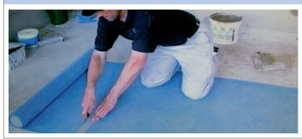
Die OTTOFLEX Abdichtbahn auf gewünschtes Format zuschneiden.
