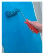
Beim Auftrag mit einem kurzflorigen Lammfellroller wird die zweite Lage der OTTOFLEX Flüssigfolie quer zur ersten aufgetragen, um eventuelle Fehlstellen in der Schicht zu vermeiden. Hinweise für die Ausführung von Verbundabdichtungen mit Bekleidungen und Belägen aus Fliesen und Platten für den Innen- und Außenbereich
