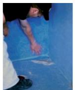
Zur Fliesenverlegung im Dünnbettverfahren ist der Fliesenkleber direkt auf die OTTOFLEX Abdichtbahn aufzutragen. Darauf sind die Fliesen vollsatt zu verlegen. Die Wahl des Fliesenklebers ist auf die Belagsart und -beanspruchung abzustimmen.
